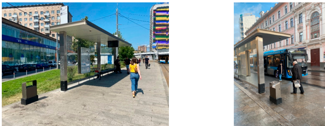
Рис. 4. Неполная защита от осадков из-за конструктивных зазоров между крышей павильона и трамваем. Источник: авторы исследования
